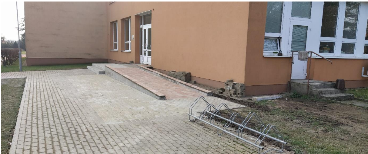
Obrázek 40: Úpravy schodiště a výstavba bezbariérové rampy při zadním vstupu do budovy ZŠ
