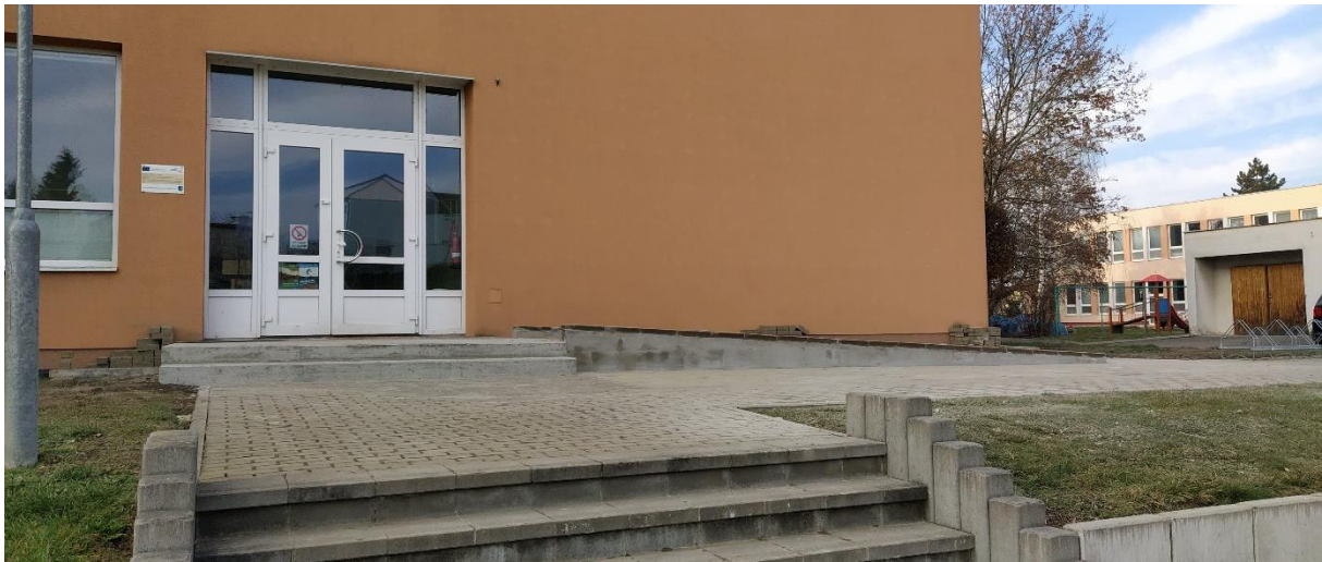
Obrázek 39: Úpravy schodiště a výstavba bezbariérové rampy při zadním vstupu do budovy ZŠ
