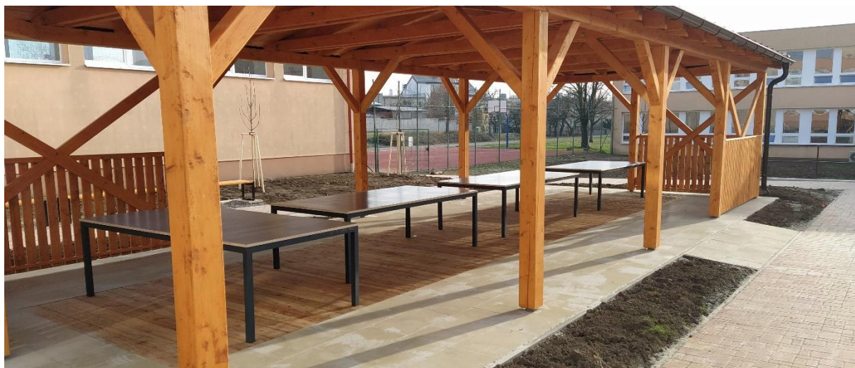
Obrázek 11: Venkovní učebna přírodovědy v átriu – dřevěné konstrukce se záhony pro pěstování bylin
