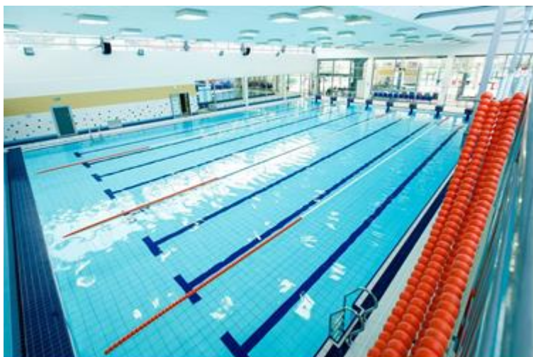
Obrázek 23 – Aquapark Uherské Hradiště – vnitřní plavecký bazén (zdroj: https://www.aquapark-uh.cz/ )
