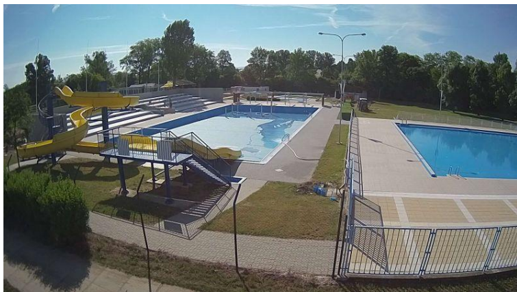
Obrázek 57 - Koupaliště Veselí nad Moravou – detail areálu (zdroj: www.google.cz )
