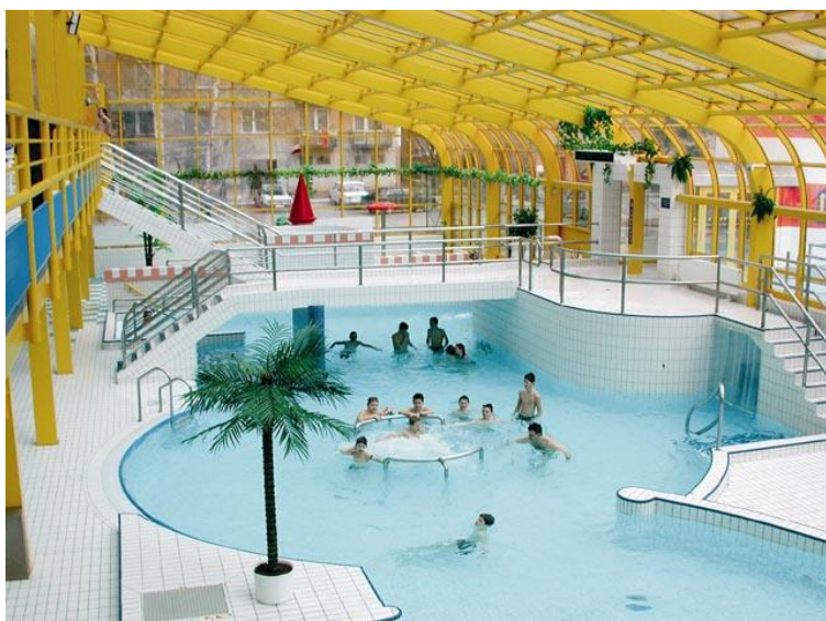
Obrázek 45 – Aquapark Vyškov – pohled na relaxační část (zdroj: www.google.com )
