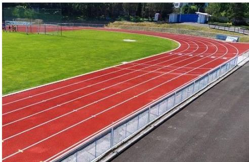
Modernizovaný atletický ovál v areálu stadionu
