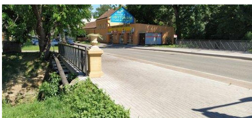
Zrekonstruovaný most M-11 na ul. Komenského
