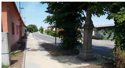
Zrekonstruovaný chodník u sv. Jana v Boršově
